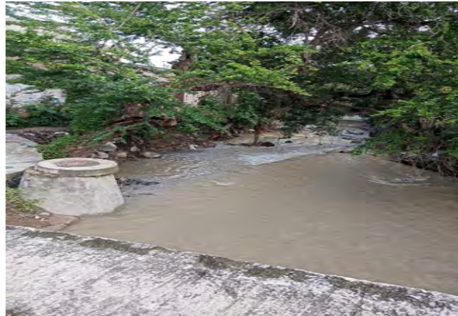
Figura 3. Daños a las viviendas adyacentes al cauce del río Huacapa
