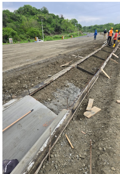
Figura 7. Elaboración de cunetas
