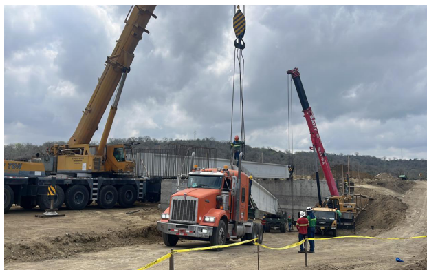
Figura 9. Izaje de vigas pretensadas mediante el uso de dos grúas
