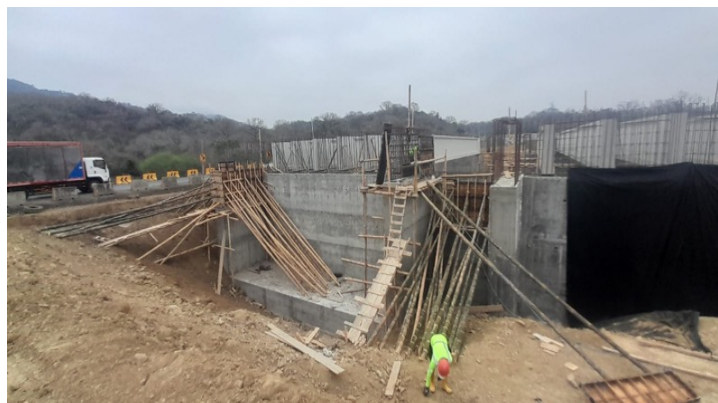
Figura 1. Encofrado en muros de ala y muro de contención
