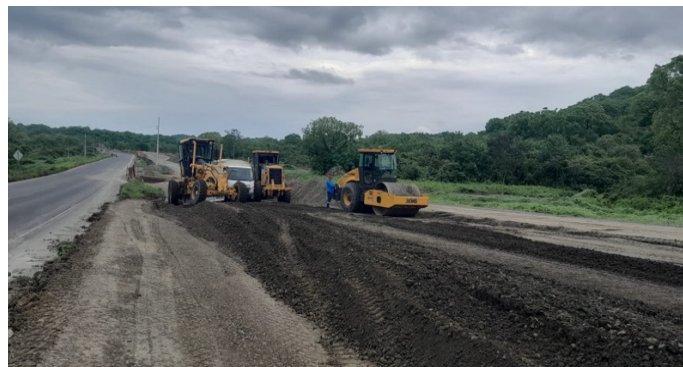
Figura 4. Tendido y compactado de subbase
