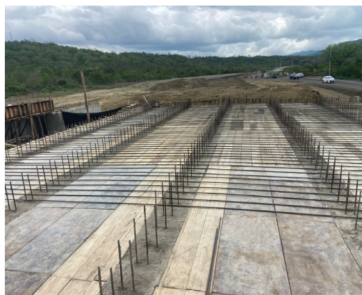
Figura 5. Armado y encofrado de losa
